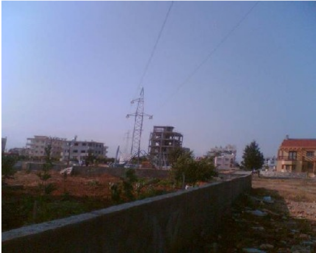
Şekil 24. Yeni Boęaziçi Köyü Gazimaęusa'daki 132 kV'luk Enerji İletim Hattının Resimleri
