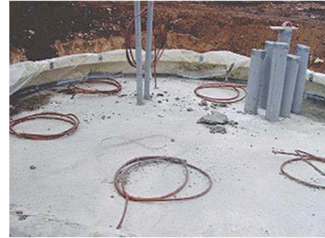
Şekil-2:Rüzgâr türbini Temel Topraklamasından Çıkan Filizler [5]
