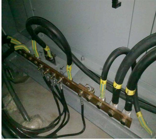
Şekil-4:Eş Potansiyel Topraklama Barası[6]
