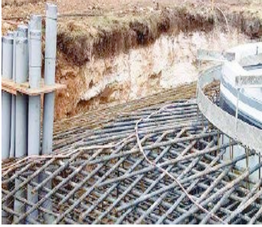
Şekil-3:Rüzgar türbini Temel Topraklaması [5]
