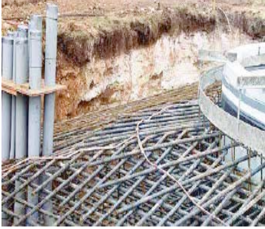
Şekil-3:Rüzgar türbini Temel Topraklaması [5]
