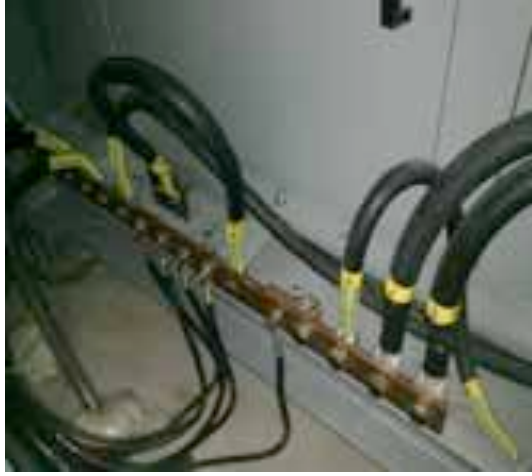
Şekil-4:Eş Potansiyel Topraklama Barası[6]
