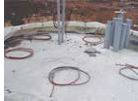
Şekil-2:Rüzgar türbini Temel Topraklamasından Çıkan Filizler [5]
